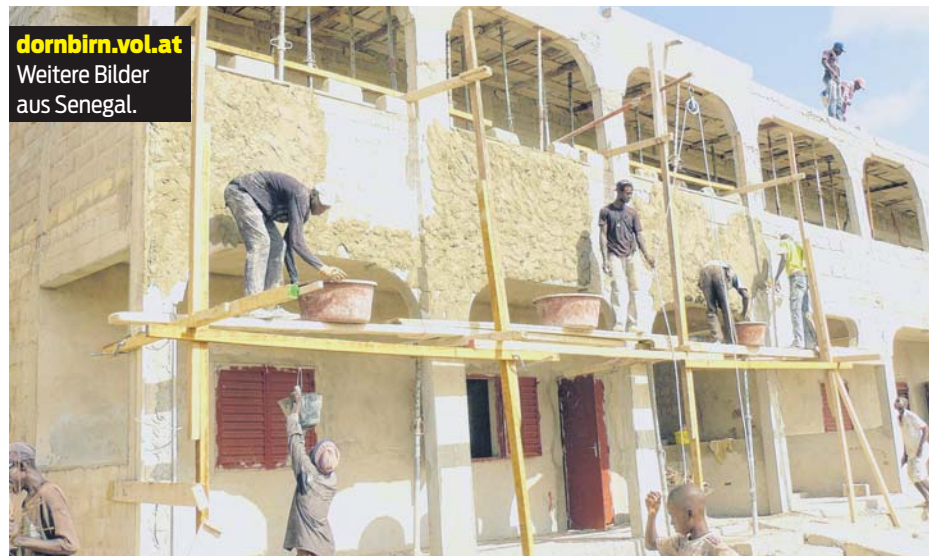
Der erste Anbau der Schule wurde von Juli bis November 2013 gebaut.
